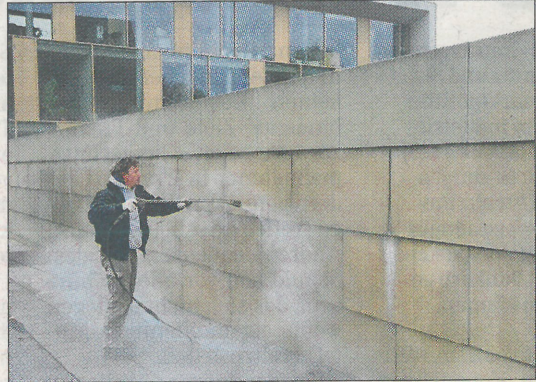
Ein Arbeiter einer Spezialreinigungsfirma entfernte gestern mit einem Dampfstrahler die Naziparolen von der Mauer der Synagoge.
