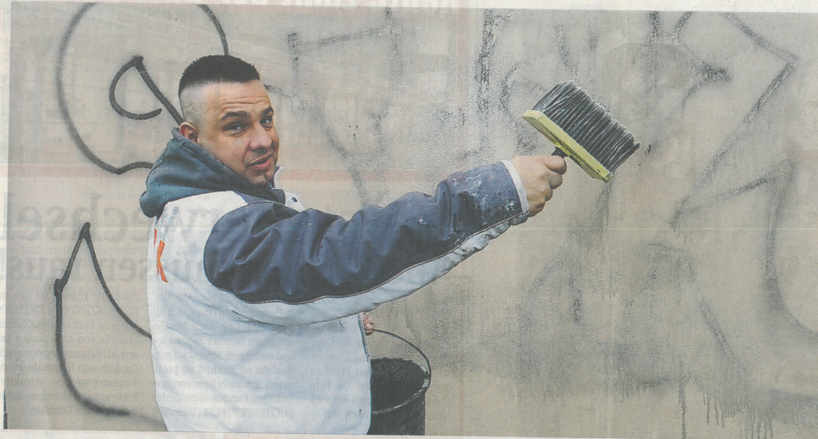
Thomas Hohmuth von der Firma „graffitti-ex“ entfernt die Schmierereien an der Fassade eines Hauses an der Güntzstraße. Mit einer chemischen Lösung wird die aufgesprühte Farbe in ihre Einzelteile zerlegt und dann mit warmem Wasser abgespült.
