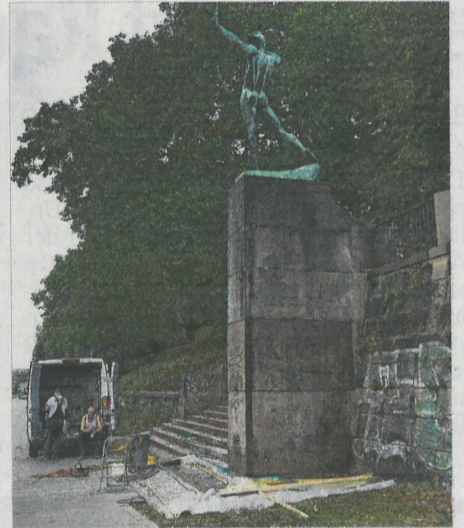
Auch das Sandsteinpodest des Bogenschützen am Königsufer haben die Dresdner Fachleute gereinigt.
