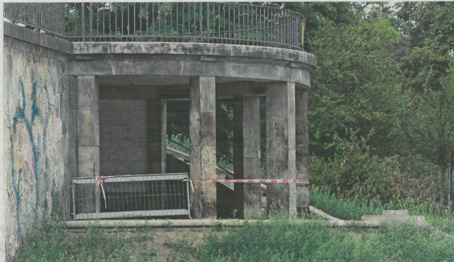
Die Graffiti-Entferner haben gute Arbeit geleistet. Zumindest im Pavillon am Rosengarten ist die Farbe entfernt, die bis zu 1,5 Zentimeter tief im Sandstein saß. Dieses typisch sächsische Gestein ist besonders saugfähig.
