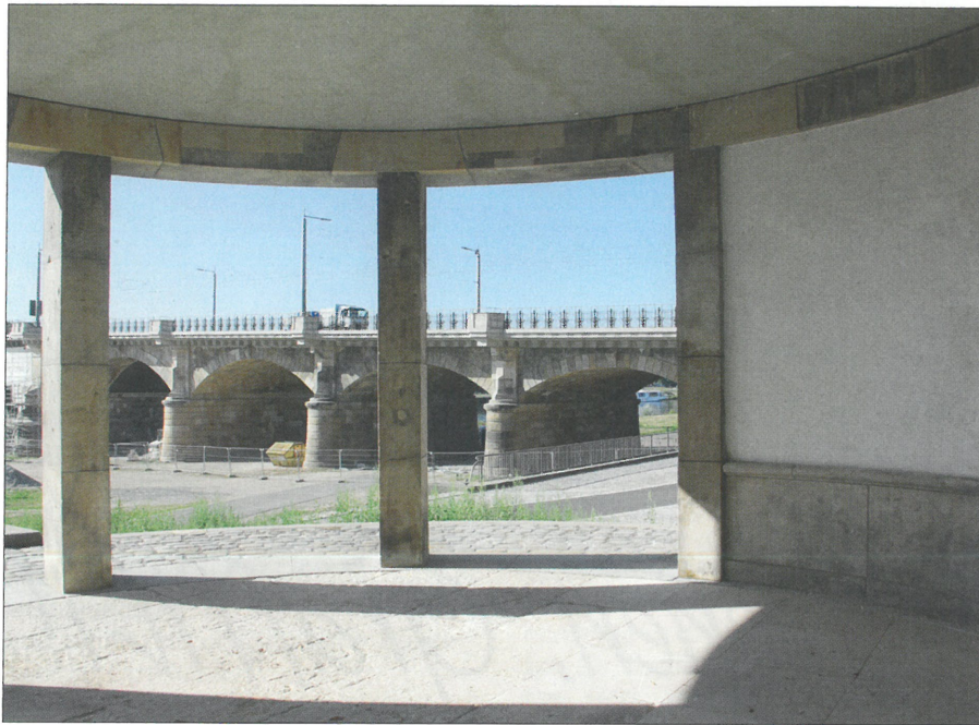
Nach Bearbeitung aller Flächen mit ausgewählten Reinigungschemikalien und Heißwasser zeigt sich der Pavillon an der Elbe wieder in graffiti freiem Zustand. (Foto: Torsten Höhne)
