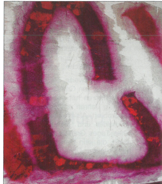
Graffiti haben einen unterschiedlich hohen Auftrag. Die Farbdicke zeigt sich nach dem Auftrag der Reinigungsmittel. Die verfärbten Stellen sind weitgehend angelöst, die hellen Stellen müssen erneut behandelt werden. (Fotos: Sabine Anton-Katzenbach)
