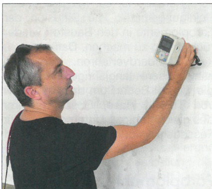
Um den ursprünglichen Fassadenzustand herzustellen, wird die bearbeitete Fläche farblich wieder angeglichen. Torsten Höhne misst dazu die Farbe der Fassade aus und lässt den Farbton anmischen.
