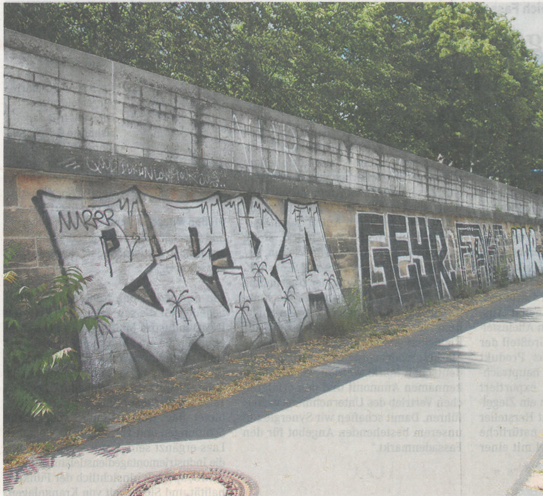
Das Team von Graffiti-ex hatte die Aufgabe, Metallic-, Farblack- und Bitumensprays von der Sandsteinmauer unterhalb des Sächsischen Landtags zu entfernen.
