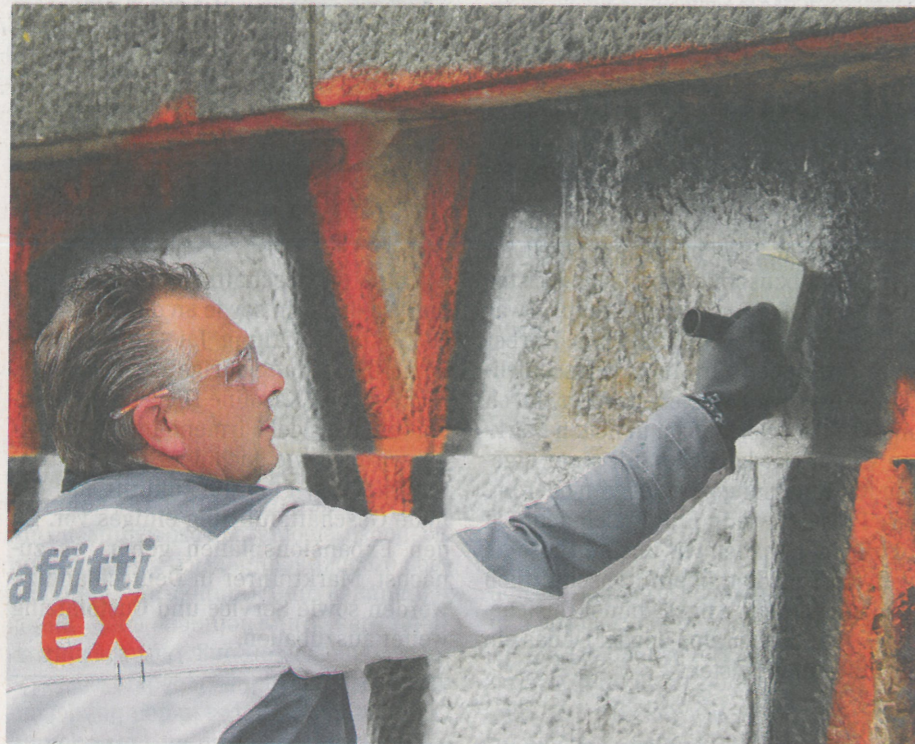
Das Metallic-Spray wurde mit einem alkalischen Reinigungsmittel behandelt, das die Aluminiumpigmente innerhalb von 15 Minuten zerstört.
