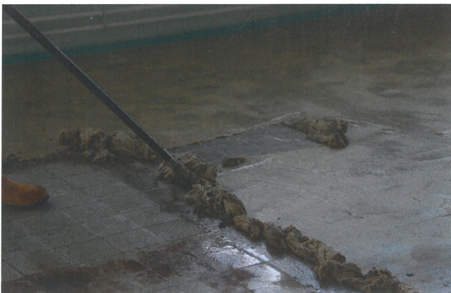
Nach einer 24-stündigen Einwirkzeit hatte der Abbeizer die Klebstoffschichten durchdrungen, so dass sie anschließend abge-spachtelt werden konnten. Bild: Torsten Höhne
