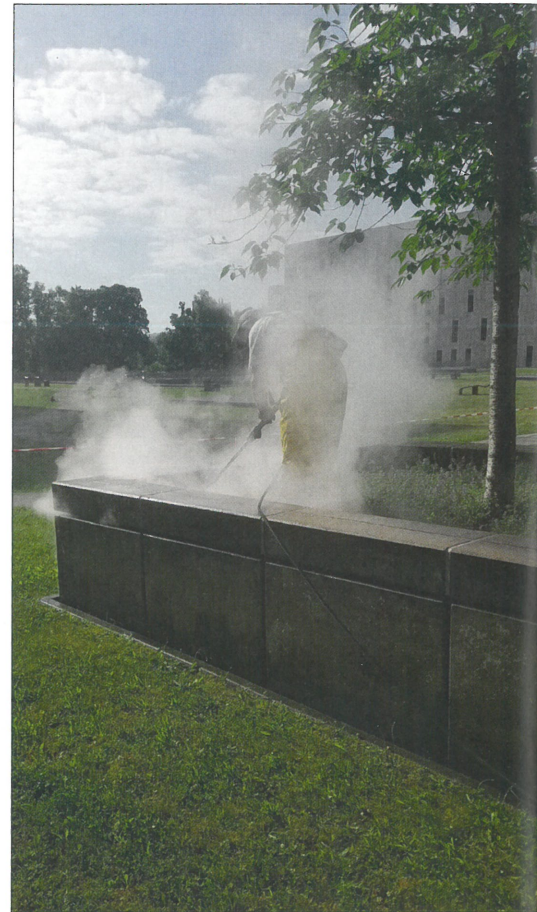
Jedes bepflanzte Betonelement wurde von innen und anschließend von außen gereinigt. (Foto: Thoralf Hase Gebäudereinigung)
