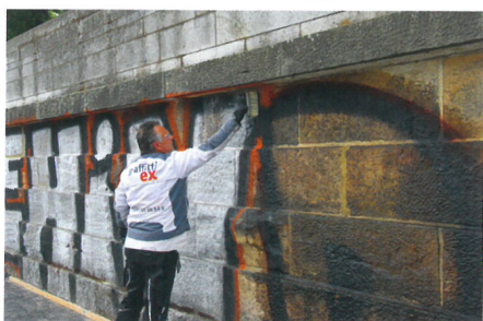
(4) Das Metallic-Spray wird mit einem alkalischen Reinigungsmittel behandelt, das die Aluminiumpigmente innerhalb von 15 min zerstört.
