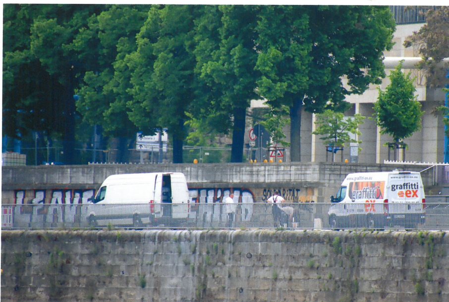
(3) Das Team von Graffiti-ex musste Metallic-, Farblack- und Bitumensprays von der Sandsteinmauer entfernen.
