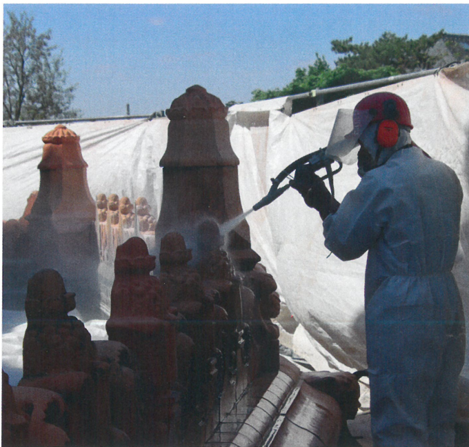
Beim Jos-Verfahren wird ein Gemisch aus Wasser und einem feinen Steinmehl durch eine Spezialdüse gepumpt.
