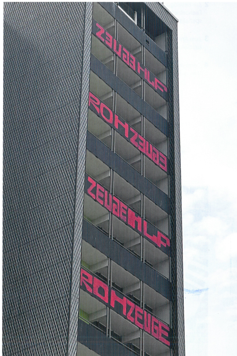
Über den öffentlich zugänglichen Bereich des Studentenwohnheims hatten Sprayer weithin Schmierereien aufgemalt.
